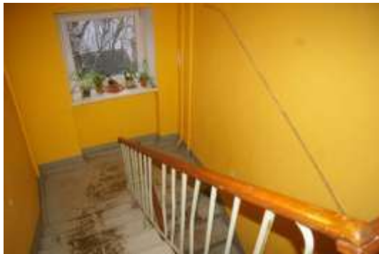
Būve ar kadastra apzīmējumu 1700 012 0507 001, koplietošanas telpa
